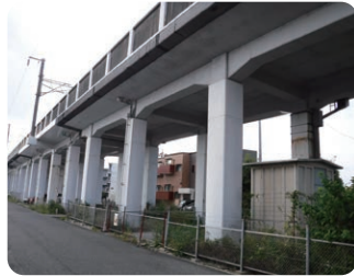
高架橋柱耐震補強
