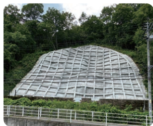
沿線の斜面の補強
