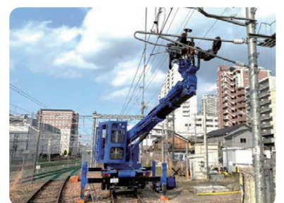
多機能鉄道重機
