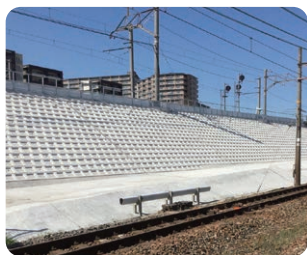
盛土区間の補強
