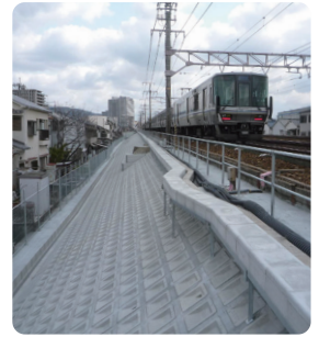
JR京都線 盛土区間ののり面对策
