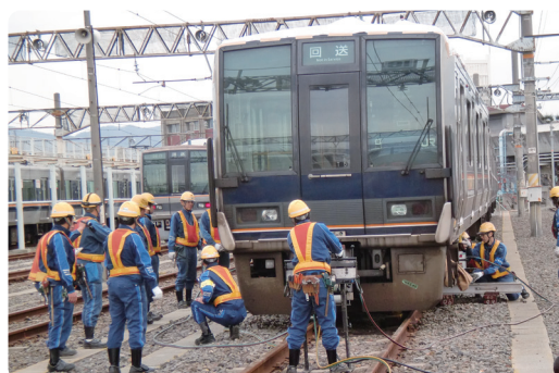
車両の脱線復旧
