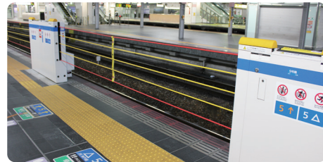
昇降式ホーム柵 〔在来線3駅に設置〕
