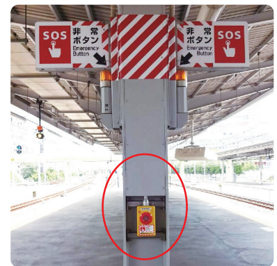
ホーム非常ボタン
