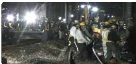
仮線路を敷設して線路を切り換えることで列車の運行を確保し、工事を進めています。
