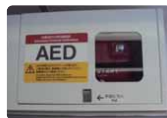
新幹線に設置しているAED
