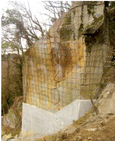
落石発生源等の安定化
