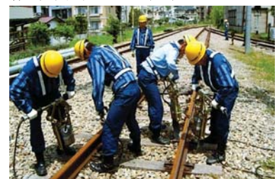
線路技術訓練センターでの訓練
