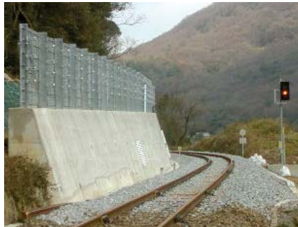
落石止柵の設置
