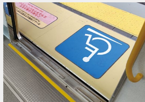
写真3：乗降口の隙間
