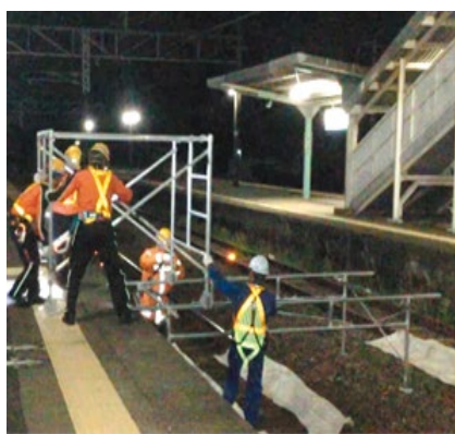
事前に組み立てた移動式足場（1段目）を載線
