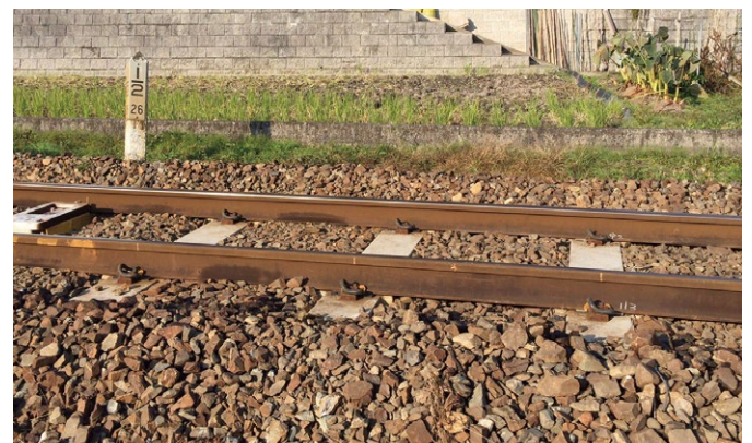
写真1：敷設中のまくらぎ配列
