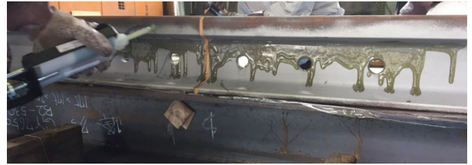
写真2：接着剤の充填作業の一例
