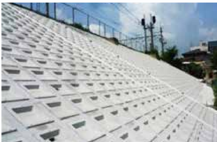
斜面对策後の盛土
